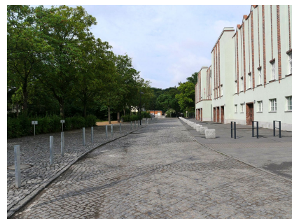
Temporäre Parkplätze vor dem denkmalgeschützten Gebäude
