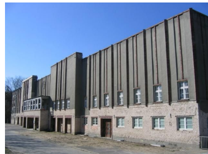
Das Gebäude vor der Sanierung
