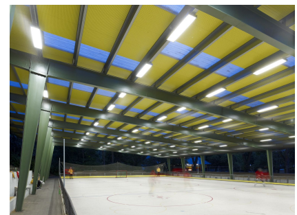
Das schräge Dach mit integrierter Beleuchtung
