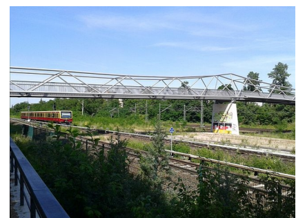
Blick vom Nord-Süd-Grünzug auf den neuen Steg
