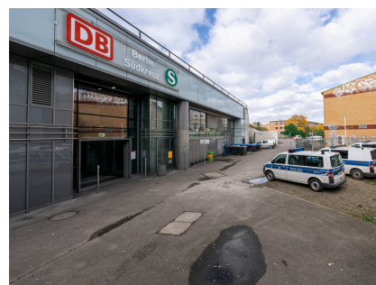
Der Eingang Nord am Bahnhof Südkreuz vor Projektbeginn
