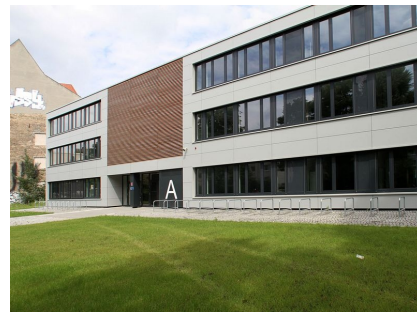
Der Modulare Ergänzungsbau an der Corinthstraße
