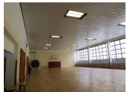
Der Innenraum vor der Sanierung
