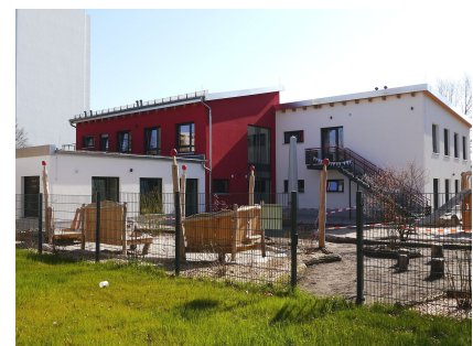
Der dreigeschossige Neubau von der Gartenseite
