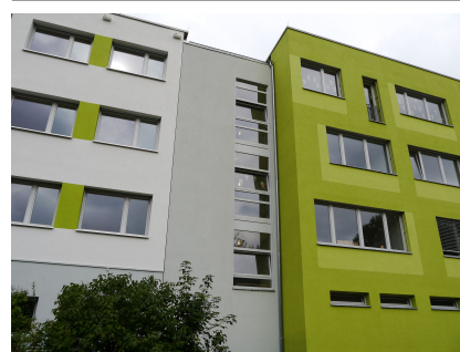
Die Fuge zum Erweiterungsbau (August 2014)
