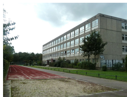
Die Schule vor Beginn des Ausbaus
