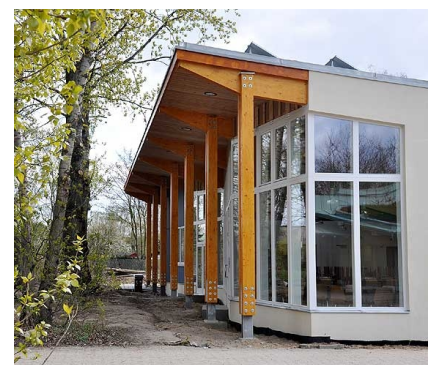
Das neue Mehrzweckgebäude in der Seitenansicht
