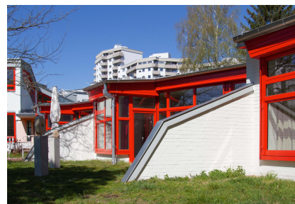
Das charakteristische Sichtmauerwerk blieb erhalten
