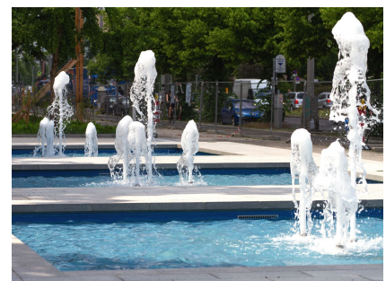
Probelauf der Brunnenanlage Anfang Juni 2019
