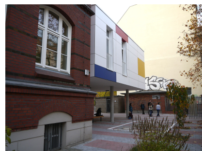
Altgebäude und Anbau in der Siegfriedstraße
