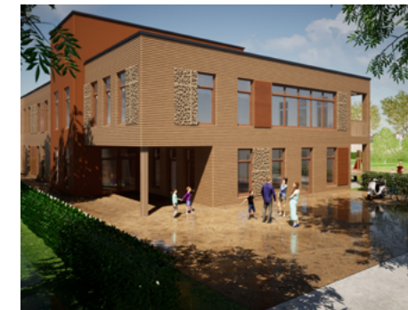
2 Für die Kita Havelländer Ring dienen Holz und Schafswolle als Bau- bzw. Dämmmaterialien. Das Dach wird als Gründach konzipiert. Neben Fernwärme kommt eine Photovoltaik-Anlage für die Energiegewinnung zum Einsatz. © LANDHERR / Architekten und Ingenieure GmbH
