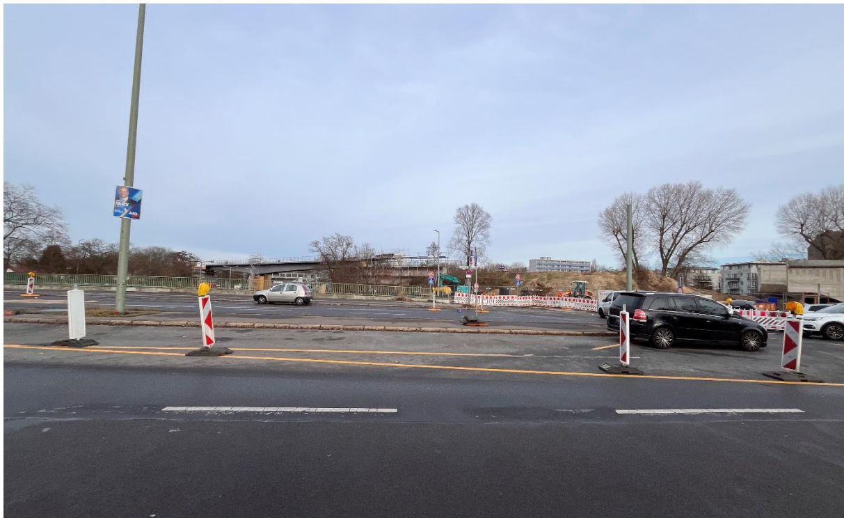
Abbildung 42 Baustelle zur Brückensanierung der U-Bahnlinie U6 | eigene Darstellung BSM mbH
