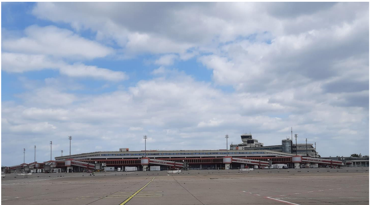
Abbildung 5 Blick auf das Terminalgebäude Flughafen Tegel | BSM mbH
