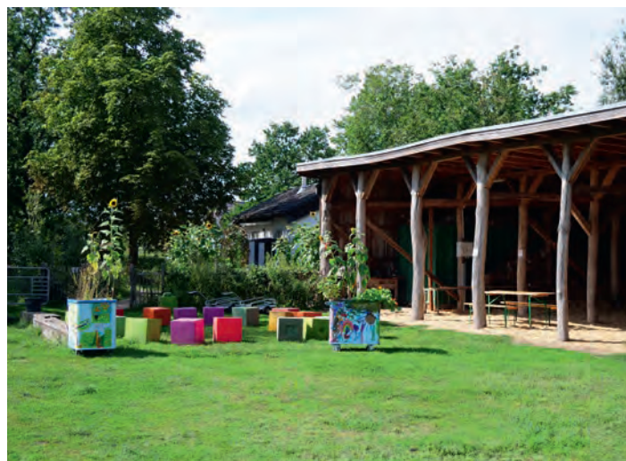
Unterrichtsraum, Bühne oder Kunstatelier – die Scheune wird viel genutzt.
