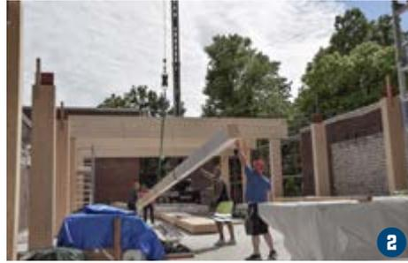
1 + 2 Der Randrähm – der obere Abschluss der Wand – wird auf die großen Binder montiert. Er dient somit als Auflage für die Dachkonstruktion.
