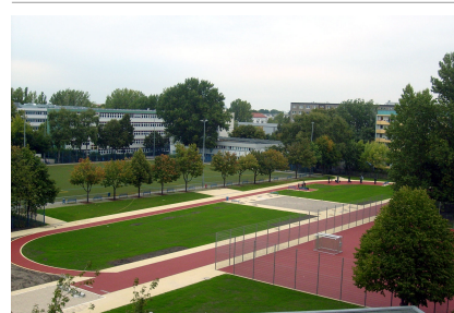
Der Spielplatz wurde komplett saniert
