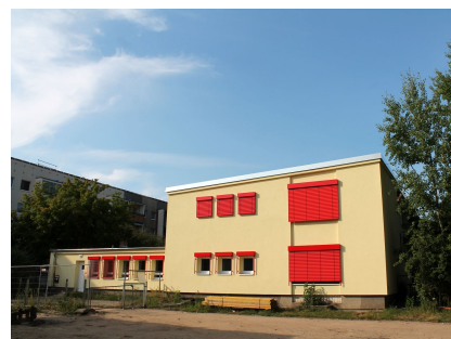
Der sanierte Südwestgiebel mit Sonnenschutz
